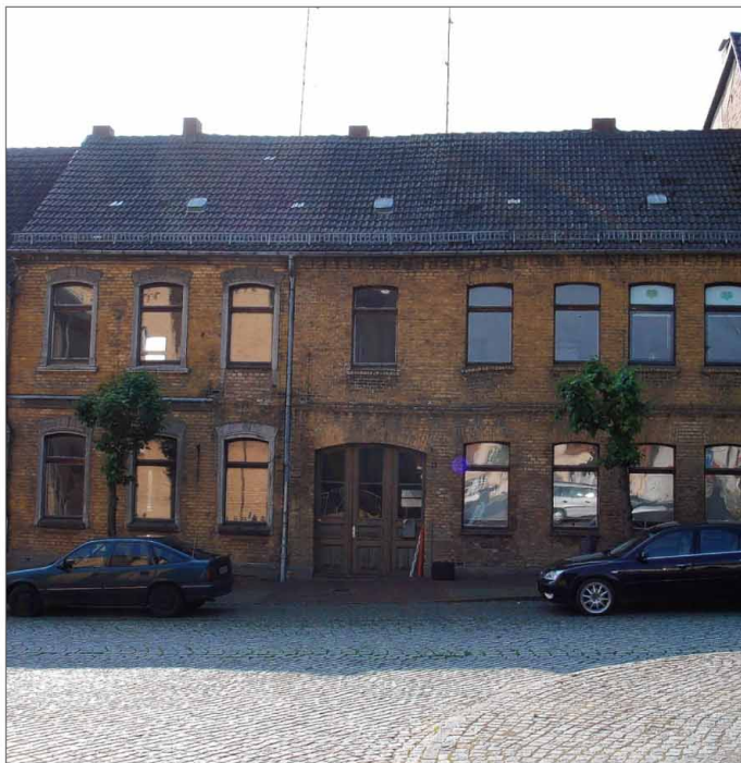
Vor der Sanierung: Aus zwei Häusern wurde eins. Foto: privat (2)
